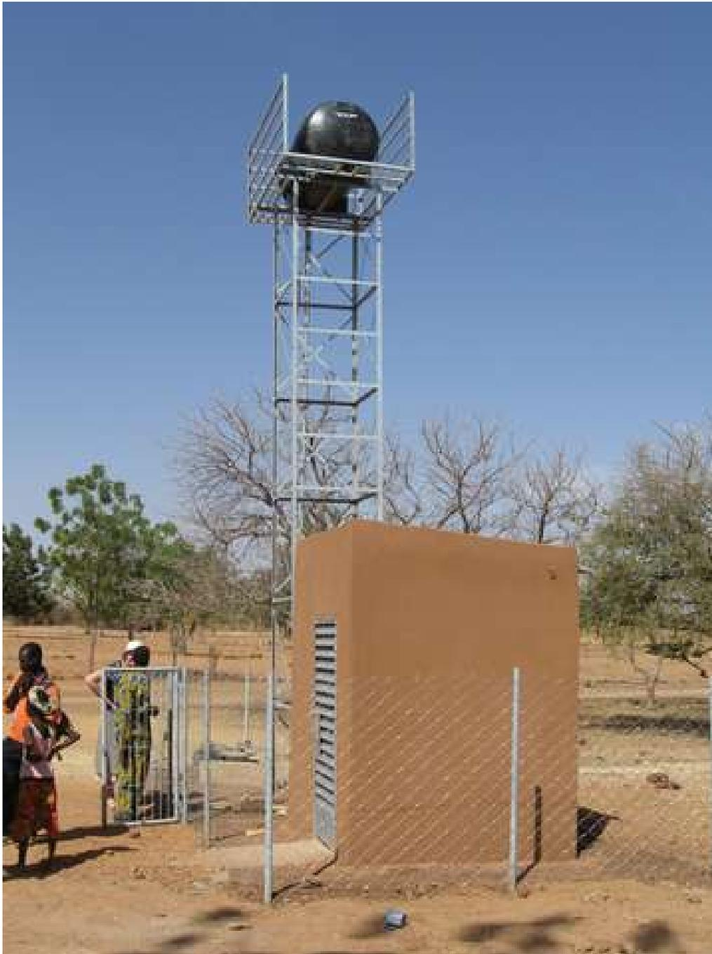
Le réservoir de 600 litres est installé à 6 m de hauteur pour éviter les problèmes de contamination de l'eau.
