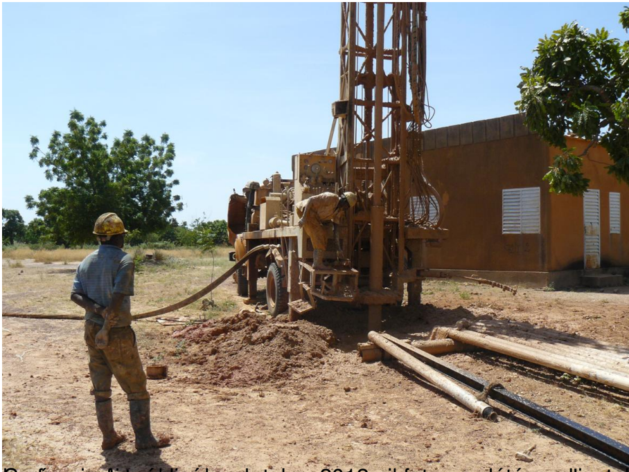
Profondeur du forage terminée en octobre 2012 : il fut complété par l'installation d'une pompe manuelle et
