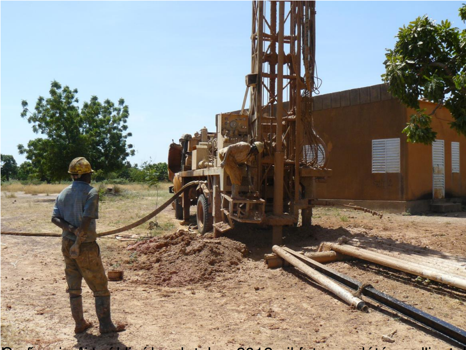
Profondeur du forage : le 10 octobre 2012 : il fut complété par l'installation d'une pompe manuelle et
