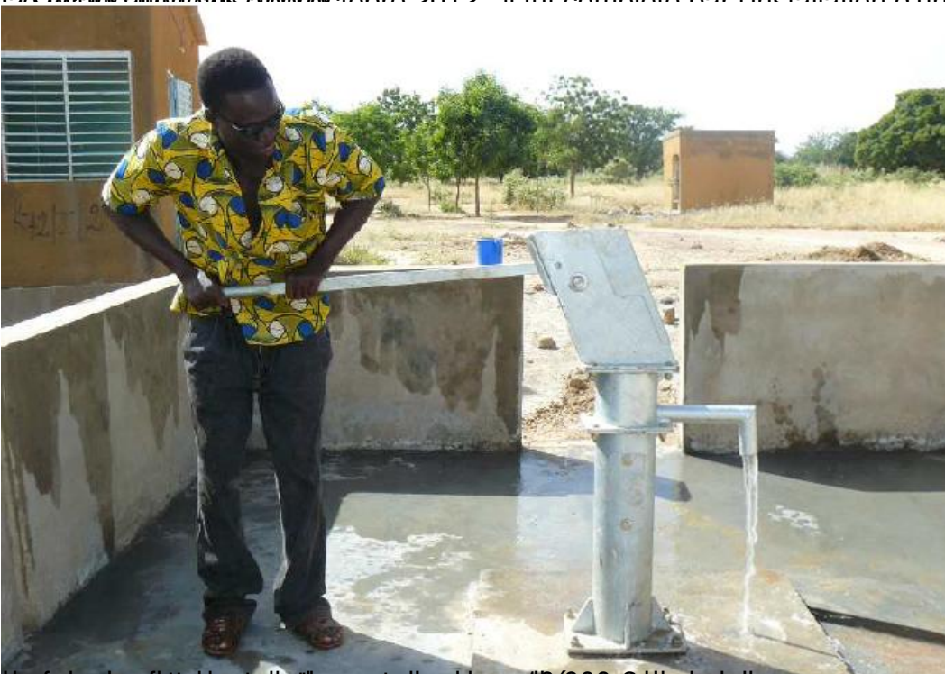
Le forage a été installé à un coût de 110 000 €. Le succès est dû à une profondeur importante
